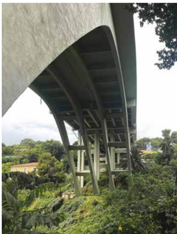
2. Il viadotto Cernicchiara
