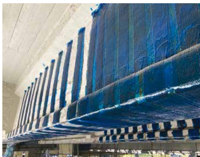
10. L'applicazione in campata del rinforzo a flessione
