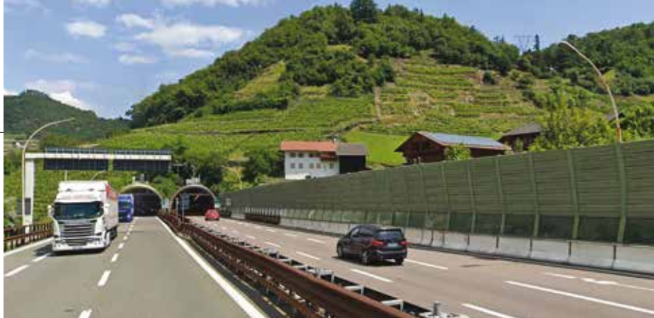
4. Le barriere fonoassorbenti oggetto di adeguamento nel comune di Chiusa
