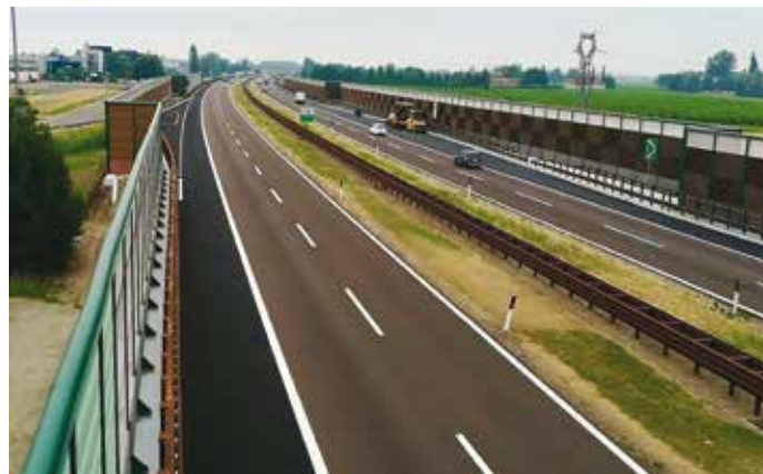
7. Una panoramica delle diverse tipologie di barriere fonoassorbenti installate da Valori Scarl sulla A22 del Brennero
