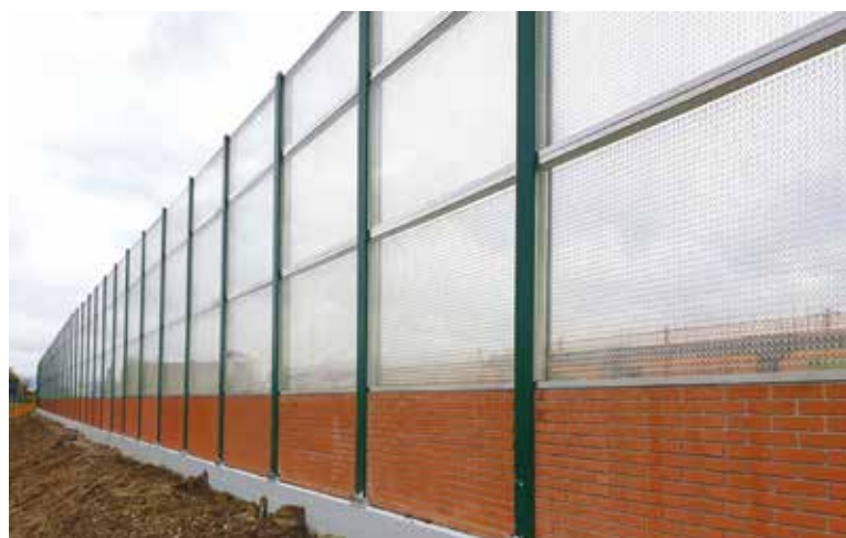
3. Un dettaglio dei pannelli trasparenti fonoassorbenti
