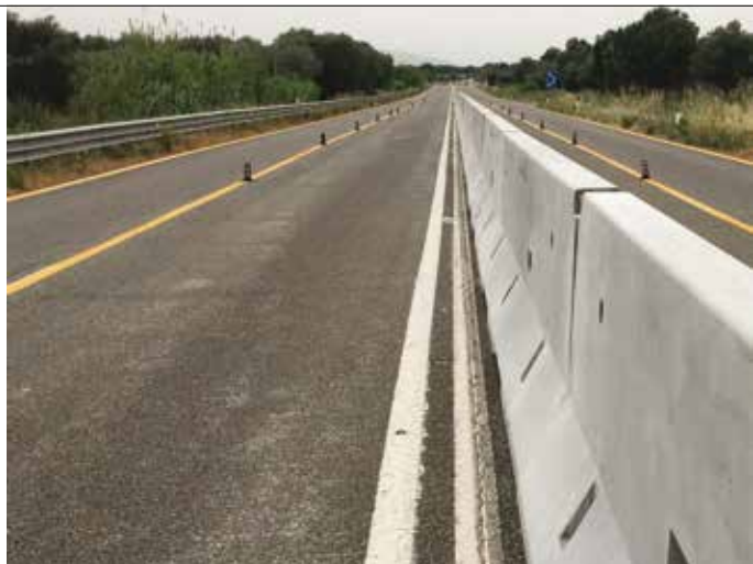
8. Le barriere NDBA spartitraffico installate dalla Valori Scarl sulla S.S. 407 "Basentana"
