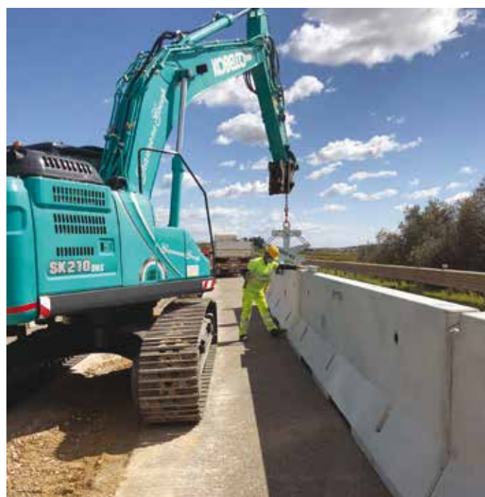
13. Il posizionamento della barriera NDBA spartitraffico
