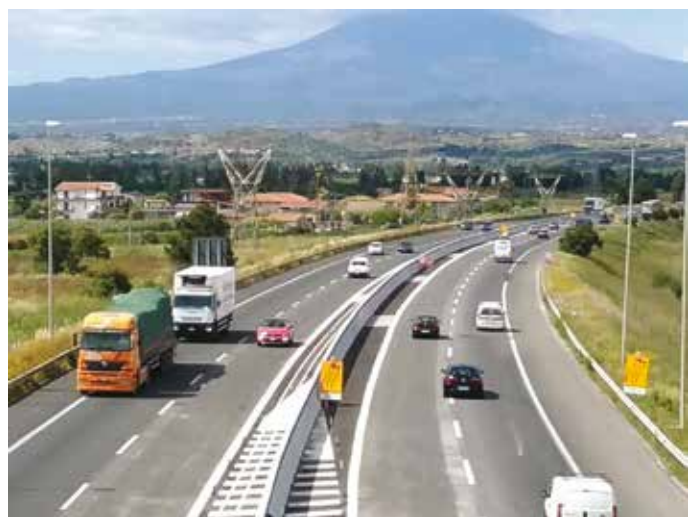
6. Le barriere NDBA installate sulla Tangenziale di Catania
