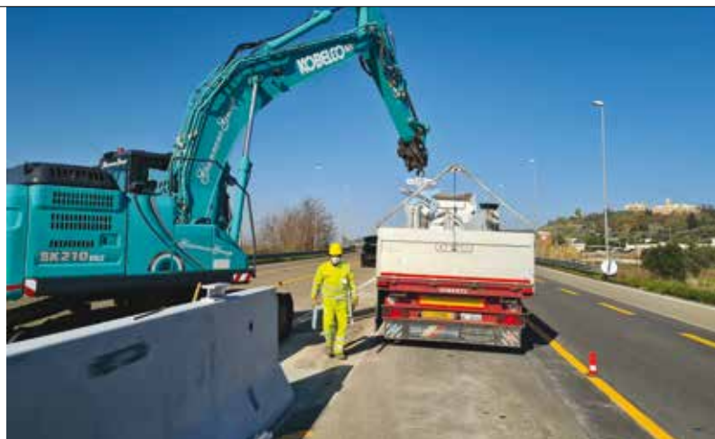
12. Lo scarico della barriera con escavatore dotato di idonea pinza
