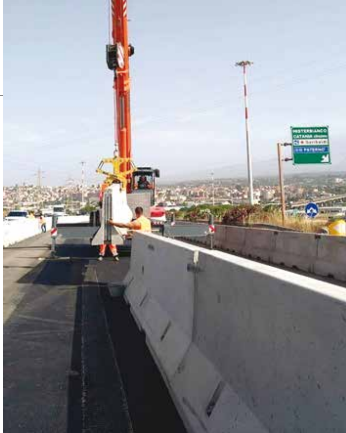
7. La posa in opera delle barriere NDBA sulla Tangenziale di Catania
