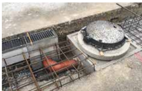
10. Un dettaglio dell'installazione della canaletta per la raccolta acque
